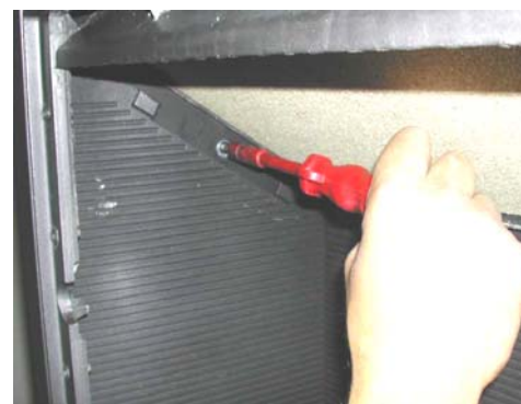
afb. 4. Schroef het hoekijzer stevig vast onder de keerplaat.
