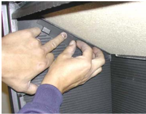
fig.3. A gauche de la chambre de combustion, placer l'équerre sous la chicane
