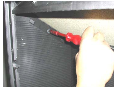
fig.4. Fixer l'équerre solidement sous la chicane
